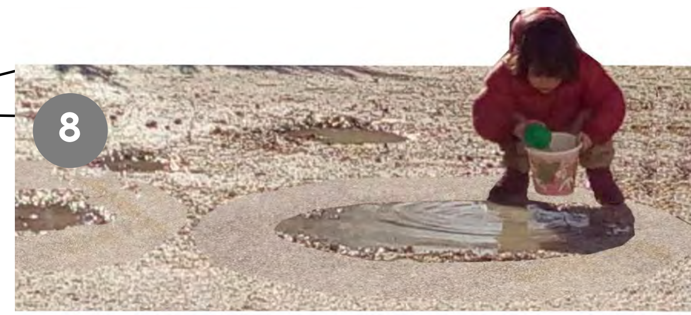
Flaques d'eau entourées de béton maigre
