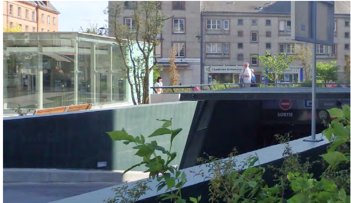
Béton vert - rampe de parking Orléans
