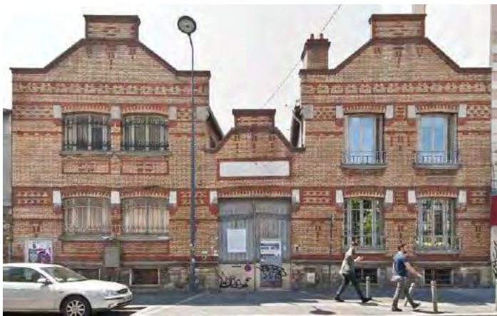
la façade rue Emile Zola et le projet paru dans « Architectures Usuelles »
