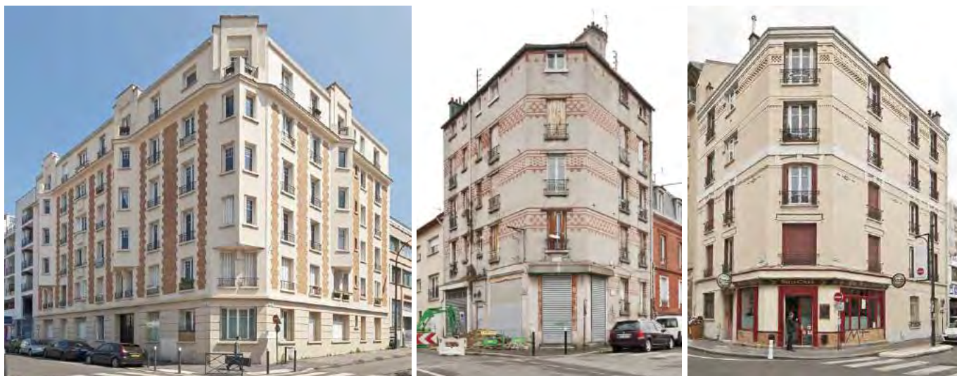
Les angles saillants en encorbellement, surmontés de frontons en attique de l'immeuble de l'architecte M. Fiedler (1930) au 17-19, rue Emile Zola, la brique polychrome de l'immeuble au 186, rue de Romainville (Charles Oudot, 1928-30), l'immeuble au 31, rue de la Solidarité construit en 1905.
