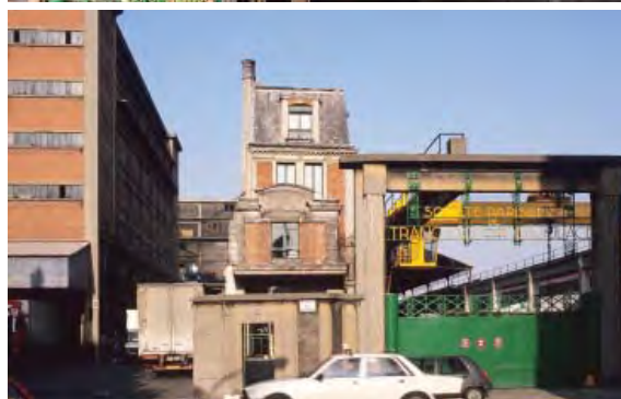
le portail rue de Lagny aujourd'hui et avant les travaux de reconversion.
