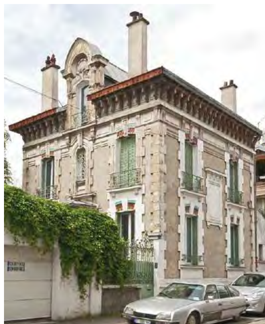
56-58, avenue Franklin : ensemble présentant deux façades principales avec cinq travées sur rue et trois sur cour. L'entrée est située sur cour ; bâtiment en « L ». Enduit, modénatures d'inspiration classique, mur de ccôteure et grille d'origine. Construction vers 1900 ; l'intérêt patrimonial est urbain avec la grande visibilité qu'offre cette maison sur ces deux façades.
