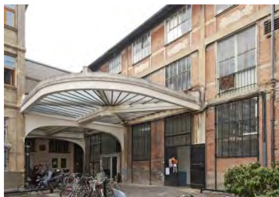
Les ateliers, le bâtiment administratif et l'auvent.
