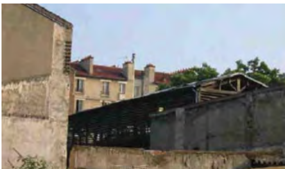
vues depuis la rue de Paris et détail de la halle Vue du site en 2015, 1962 et 1920
