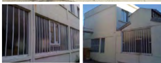
Vue du site depuis la rue de Paris;
