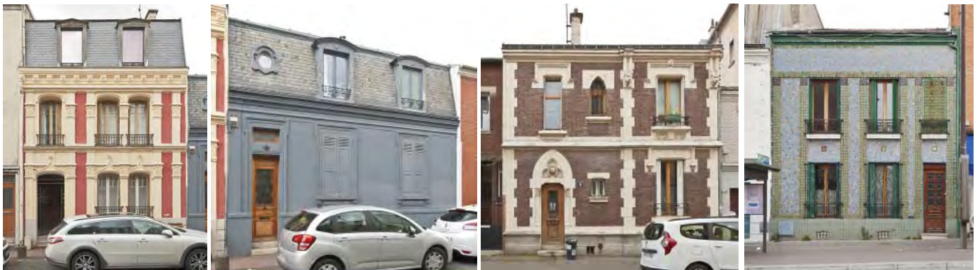
Des maisons éclectiques d'inspiration gothique ou classique, 76, 74b, rue de Vincennes et 2, rue Malot. Le 76 Vincennes, construit par Emile Travailleur en 1906 mêle les styles. Le 50, Bd Chanzy, construit en 1925-30 par l'architecte L. Raighasse marque fortement le paysage urbain de la place du marché par la polychromie de sa façade en émaux de Briard.
