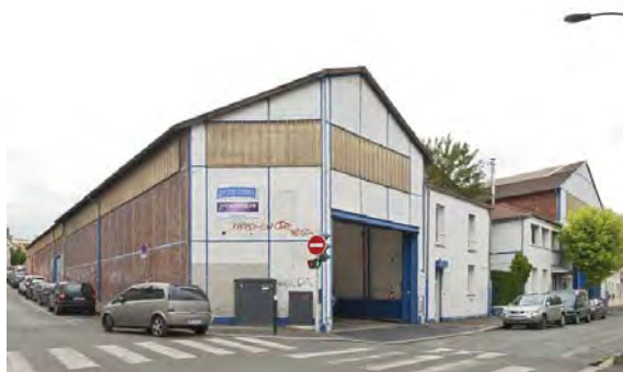
Vue de l'angle des rues Jeanne d'Arc- Colmet - Lepinay; Vue du site en 1920, 1962, 2015
