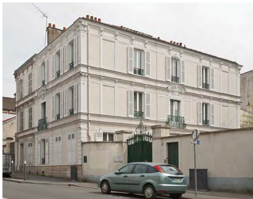
56-58, avenue Franklin : ensemble présentant deux façades principales avec cinq travées sur rue et trois sur cour. L'entrée est située sur cour ; bâtiment en « L ». Enduit, modénatures d'inspiration classique, mur de ccôteure et grille d'origine. Construction vers 1900 ; l'intérêt patrimonial est urbain avec la grande visibilité qu'offre cette maison sur ces deux façades.
