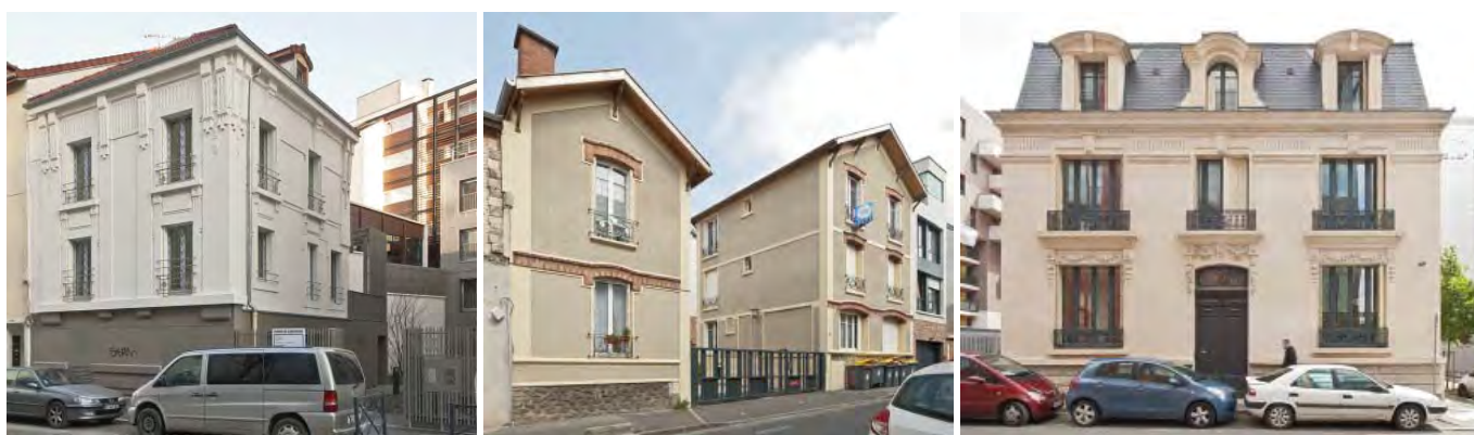
Les logements patronaux comme vestiges des sites industriels : l'ancienne usine Roultext au 19-21 Stalingrad avec ses modénatures Art Déco a été réhabilité tout comme les deux maisons d'ingénieur de l'architecte André Taiclet, construites en 1927 pour le site des anciennes chaudronneries Morel ; le 89, rue Marceau, vestige de la scierie Guyot.
