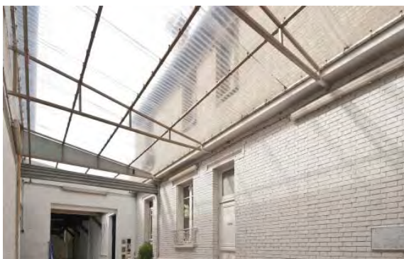
la halle qui couvre l'ancienne cour de livraison ; le porche d'accès entre les deux bâtiments symétriques;
