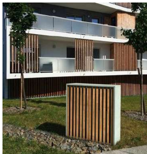
Exemples de coffrets techniques et descentes d'eaux pluviales intégrées de façon qualitative
