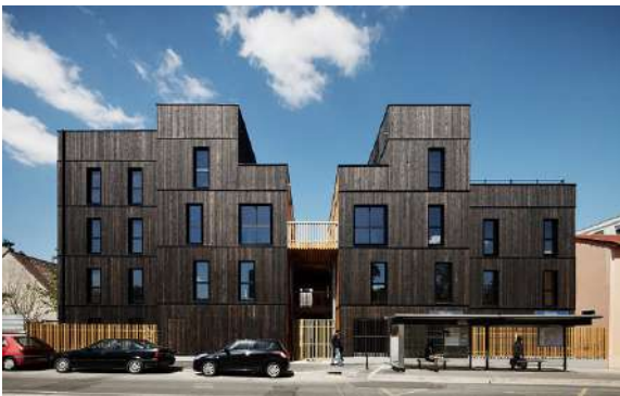
3 rue Dolet - 18 logts - 2011 OPH Montreuillois - LA Architecture
