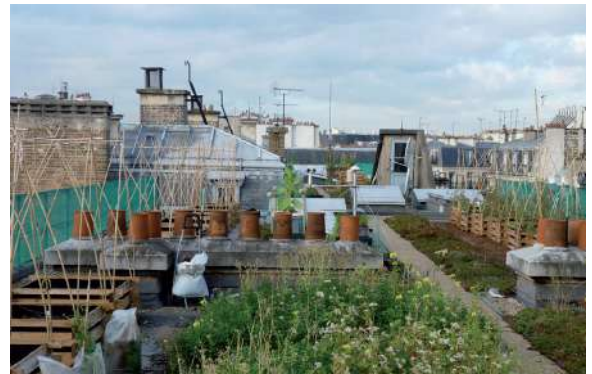
Exemple d'une toiture terrasse végétalisée (Paris Ve, Agrotech Paris)
