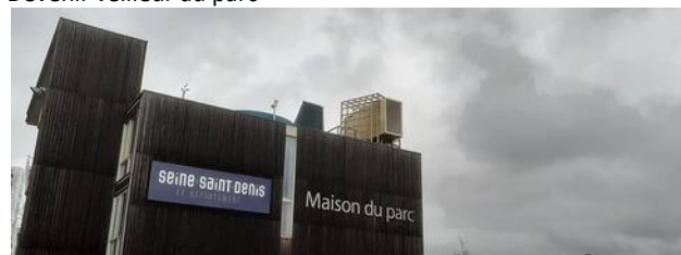
Structure en bois vue depuis la pelouse
