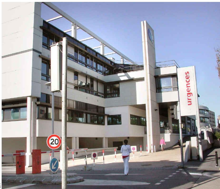
L'entrée des urgences du centre hospitalier intercommunal André-Grégoire.
