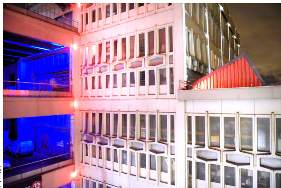
La zone industrielle verticale Mozinor a été la première du genre en Europe.
