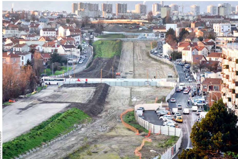
Un vaste chantier qui offre une occasion unique de redessiner le paysage.
