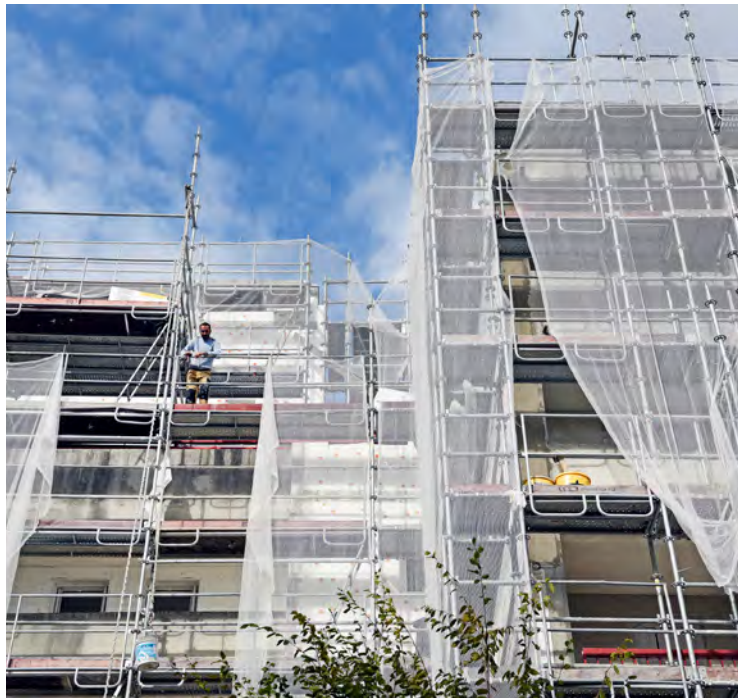
Rénovation thermique rue Rabelais et avenue de la Résistance.
