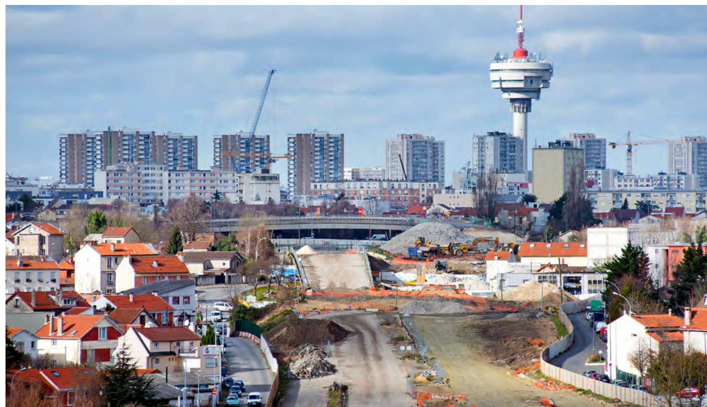
Vue du chantier du tram T1 avec, au fond, le tronçon de l'A186 qui sera découpé cet été.
