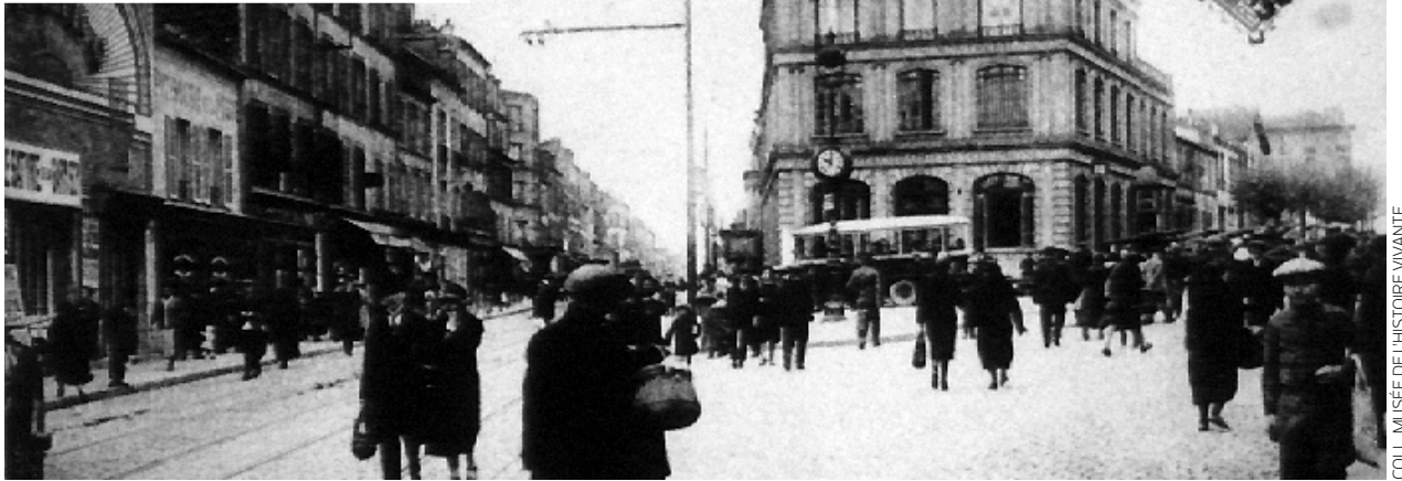
En 1889, la malle-poste s'arrêtait à la poste de Montreuil, située à la Croix-de-Chavaux, carrefour régional depuis des siècles. Les cochers y changeaient d'attelage. Désormais, le bâtiment accueille le siège des syndicats locaux.
