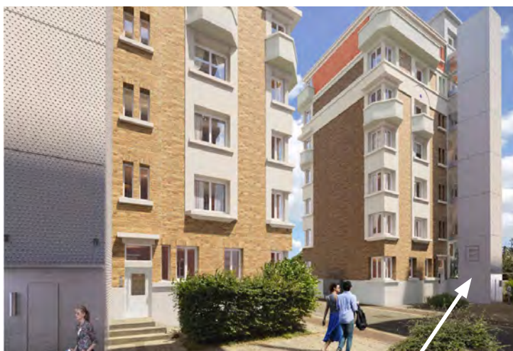
Au bout de cette flèche, un des ascenseurs extérieurs.
