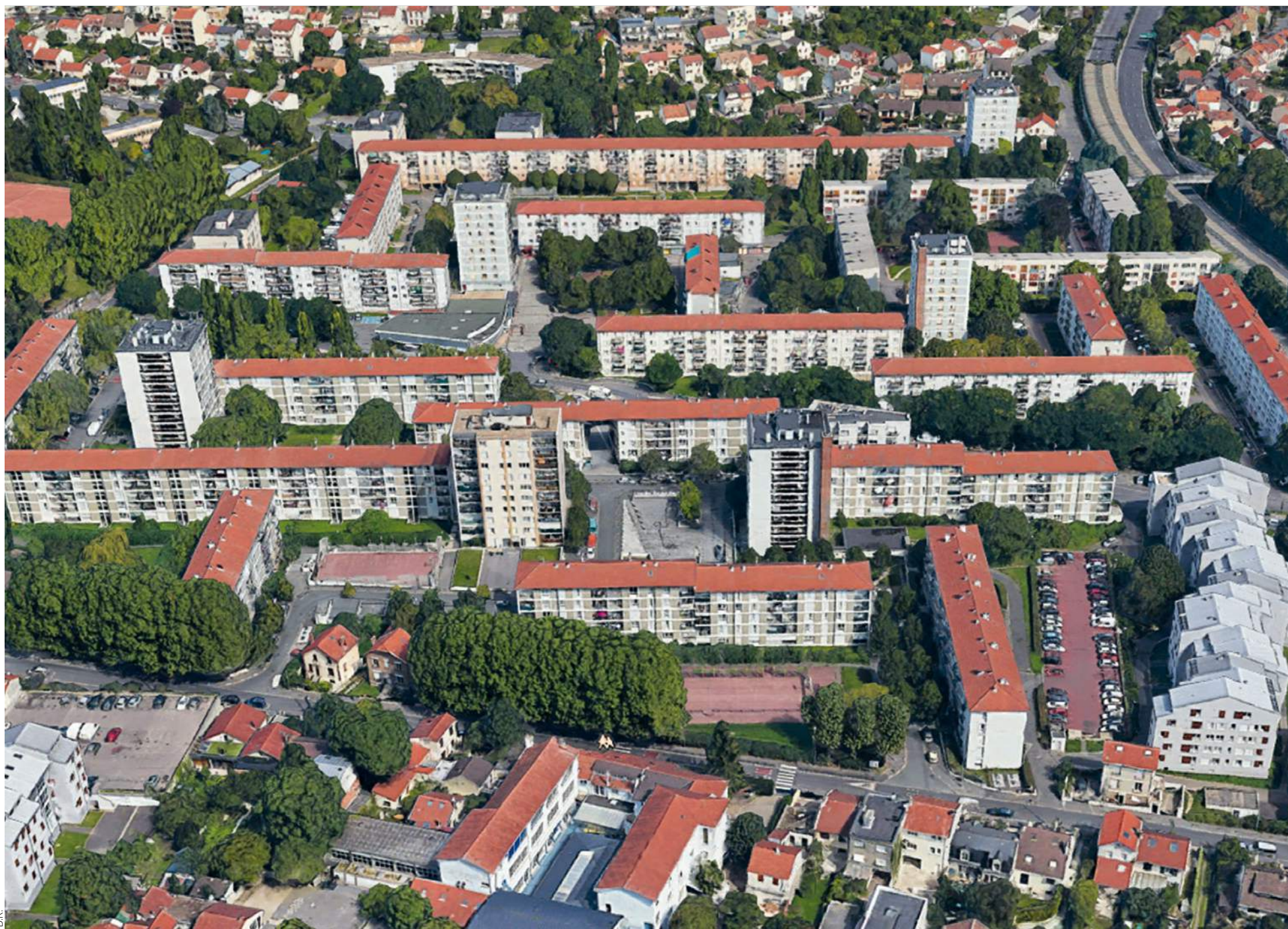
Les rénovations de la résidence Montreuil A1 (sur la moitié supérieure de cette photo) concerneront 578 logements, qui ont été construits en 1964.
