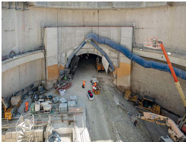
Le 20 septembre, le tunnelier Sofia sera officiellement baptisé.
