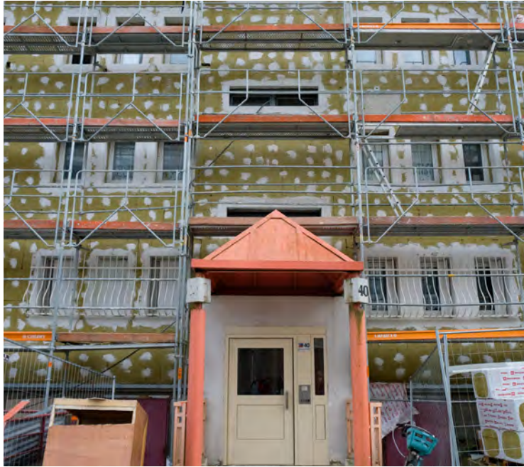
Les travaux de réhabilitation au Morillon concernent aussi bien les façades que les intérieurs des logements.
