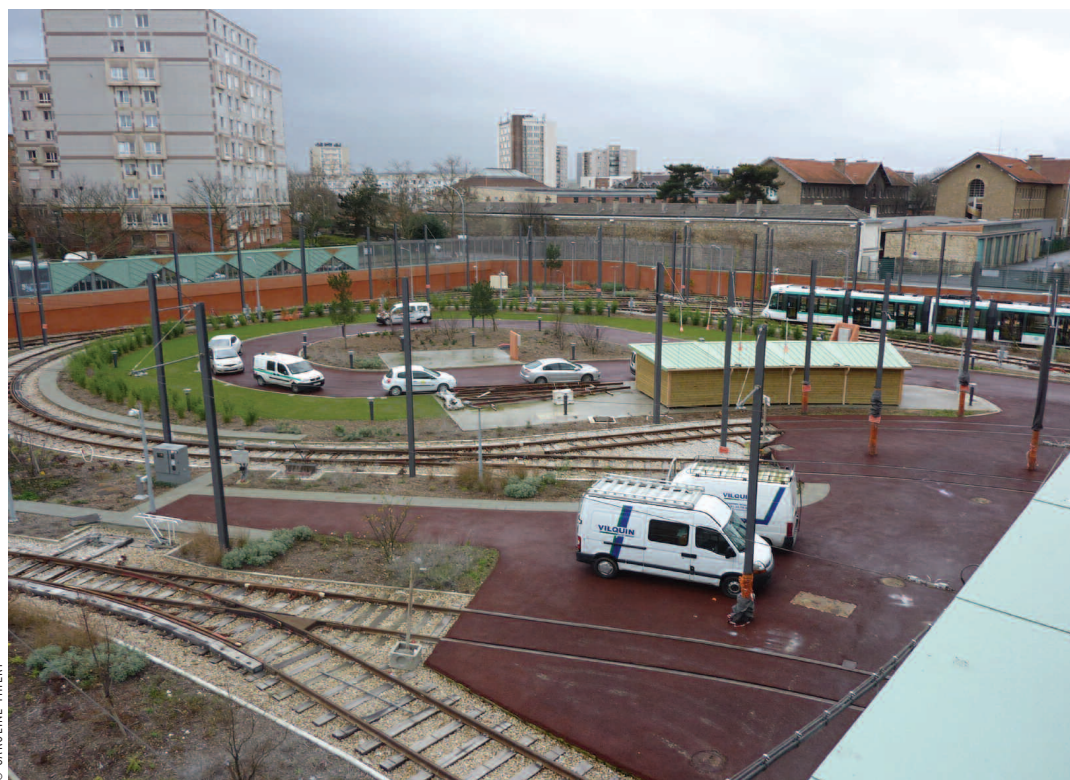
L'espace de stockage des rames du tramway du site de maintenance et de remisage du T2 à Bezons.
