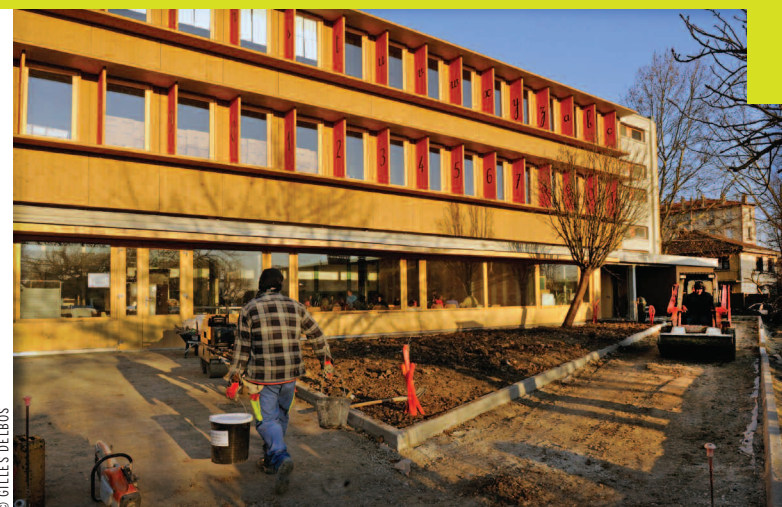
La nouvelle façade de l'école Henri-Wallon, en cours de finition.
