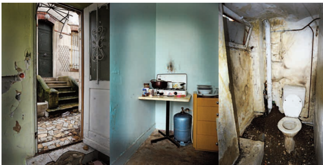
Le logement occupé par M. Hadji est frappé d'un arrêté d'insalubrité irrémédiable assorti d'une interdiction d'habiter. Il lui était pourtant loué 800 euros par mois...
