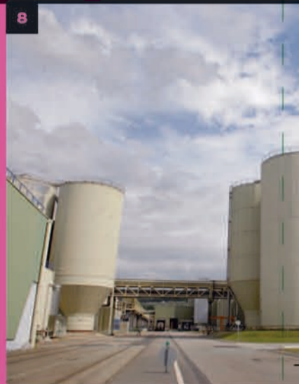
10 Deuxième étape, l'épuration. Elle permet d'extraire par la force centrifuge les éléments plus fins comme le sable, le verre et les agrafes afin d'obtenir une matière propre.
