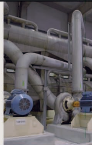
10 Deuxième étape, l'épuration. Elle permet d'extraire par la force centrifuge les éléments plus fins comme le sable, le verre et les agrafes afin d'obtenir une matière propre.
