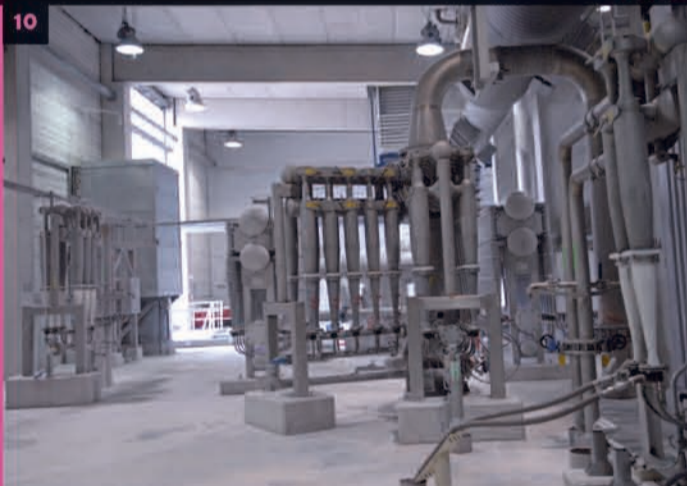
10 Deuxième étape, l'épuration. Elle permet d'extraire par la force centrifuge les éléments plus fins comme le sable, le verre et les agrafes afin d'obtenir une matière propre.
