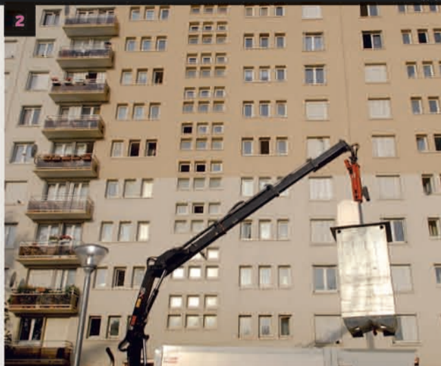
1 & 2 L'utilisateur dépose ses vieux papiers dans un des 44 conteneurs enterrés destinés à la collecte des emballages, journaux et magazines parmi les 98 points d'apports volontaires enterrés (PAVE) mis en place par la Ville à proximité des immeubles collectifs pour mettre le tri sélectif à la portée de tous.
