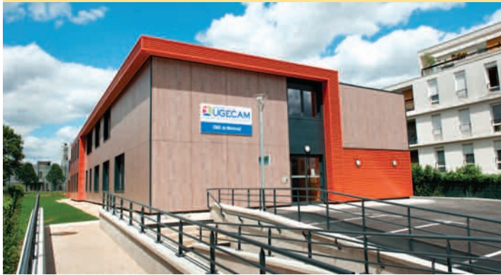
L'installation des bâtiments provisoires qui seront utilisés pendant la suite du chantier est terminée.
