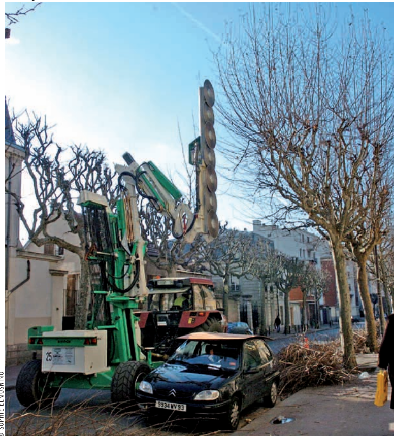
Le gros du travail est réalisé par le tracteur agricole d'élagage et ses lames de scie qui tournent sur un bras long de 3,50 mètres. Passe ensuite, pour les finitions à la main, un élagueur en nacelle automotrice.
