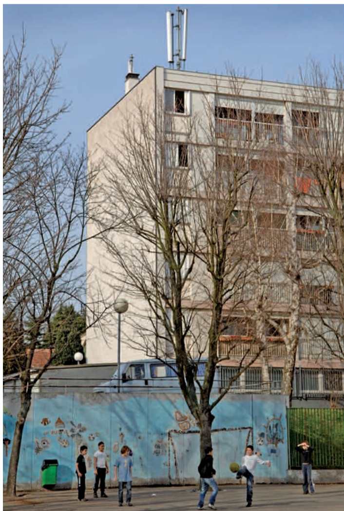
Quarante-deux stations de base à Montreuil. Orange souhaite implanter trois nouvelles antennes pour la couverture 3G. Suite à la mobilisation de parents d'élèves et aux négociations de la Ville avec l'opérateur, l'antenne située sur un immeuble face à l'école d'Estienne-d'Orves va être déplacée.
