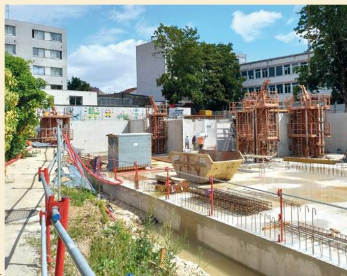
DR Construction de la future école maternelle Guy-Môquet-d'Estiennes-d'Orves.
