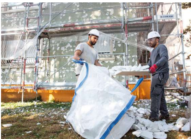
Pose d'une isolation thermique en façade.
