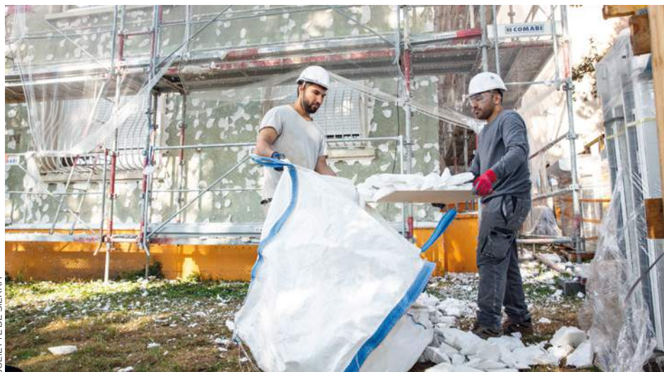
Pose d'une isolation thermique en façade.
