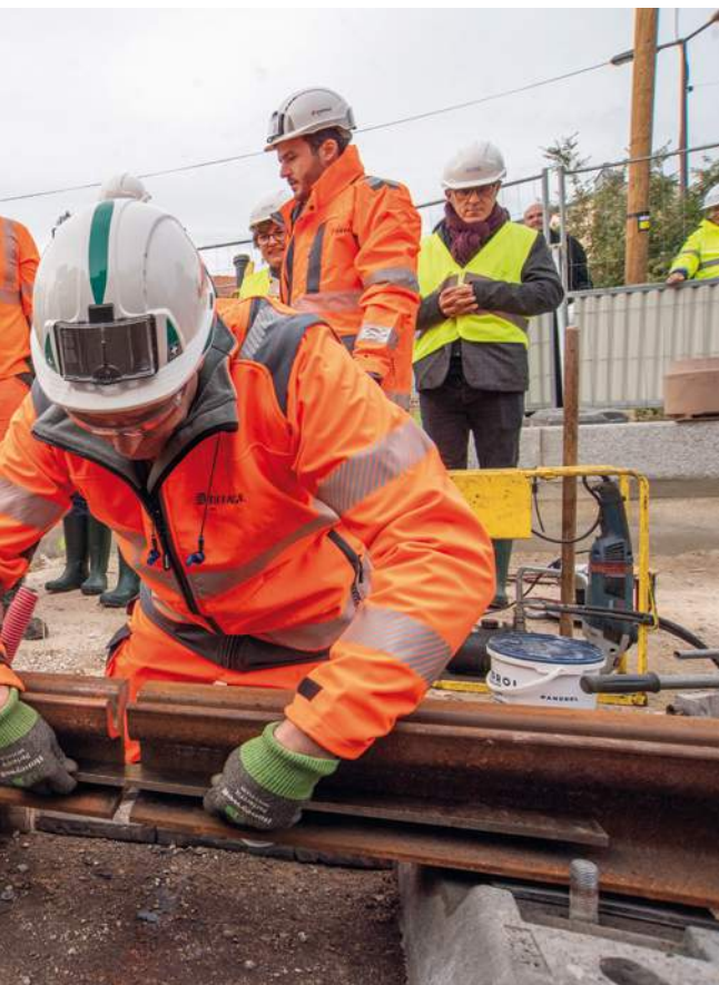
rails du futur tramway, en septembre dernier.
