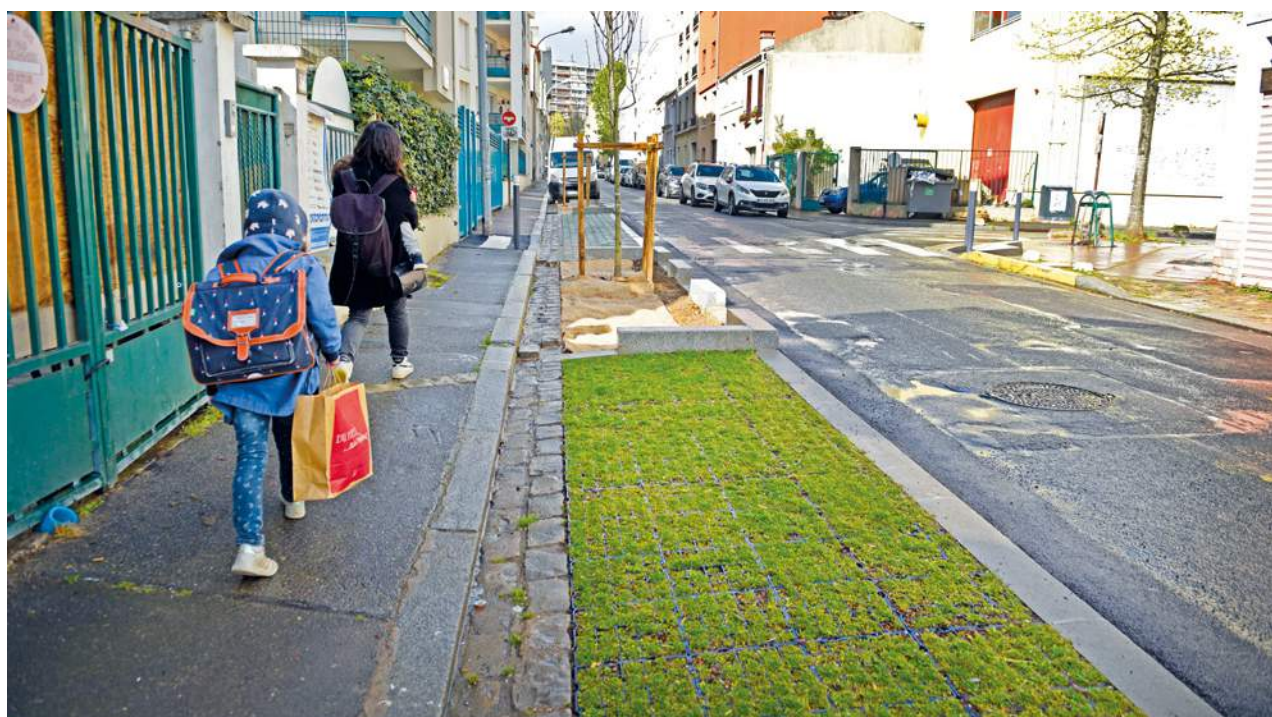
En débitumisant, on permet aux eaux de pluie de pénétrer le sol et, ainsi, d'alimenter les nappes phréatiques.
