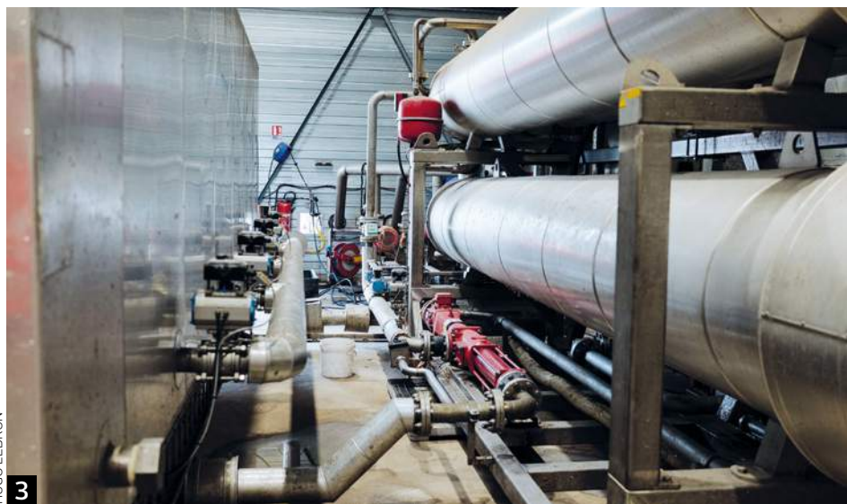
3 La « soupe » arrive dans l'hygiéniseur, qui va la chauffer à 70 °C pendant une heure pour éliminer les bactéries.
