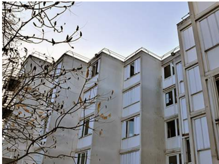
Rue Édouard-Branly, la façade du foyer.
