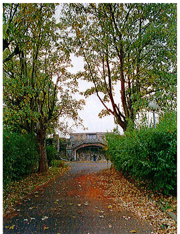
Escaliers et allée d'arbres des anciens réservoirs du Sedif, préservés et mis en valeur dans la ZAC Boissière Acacia
