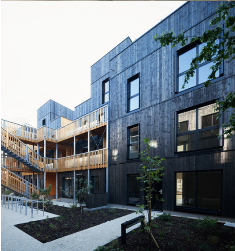
3 rue Dolet - 18 logts - 2011 OPH Montreuillois - LA Architecture
