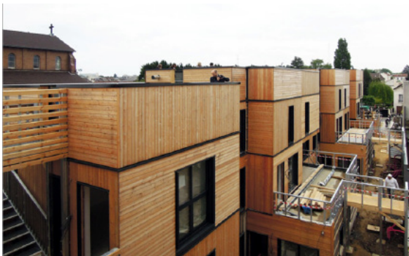
49 rue E. Branly - 17 logts - 2011 OPH Montreuillois - LA Architecture
