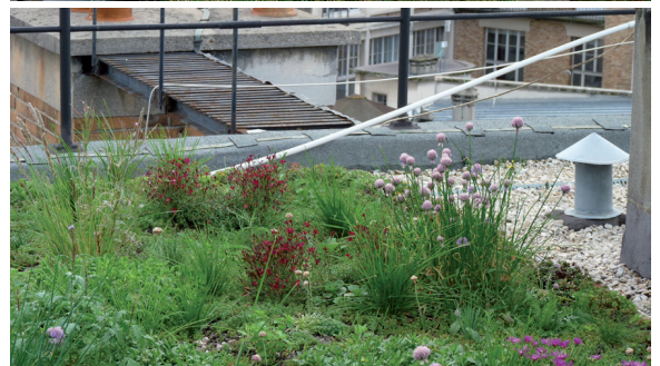
Exemple d'une toiture terrasse végétalisée (Paris Ve, Agrotech Paris)
