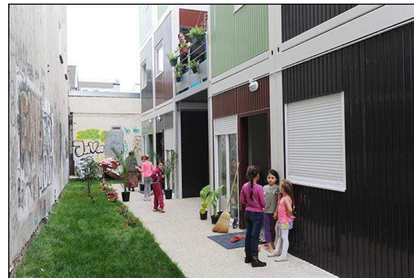
Hébergements d'urgence dit « logement-passerelle »
