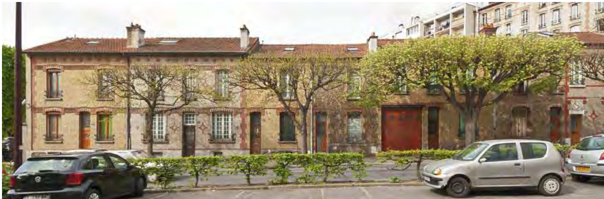
Des séquences au gabarit préservé : La séquence des maisons de ville au 9-25, Bd Henri Barbusse : suite de neuf maisons de ville à deux ou trois travées, brique polychrome et meulière, toiture à deux pans en tuiles mécaniques ; certaines trames ont été modifiées (porte de garage)
