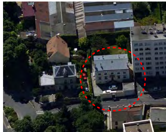
Vue oblique depuis la rue (2012)
