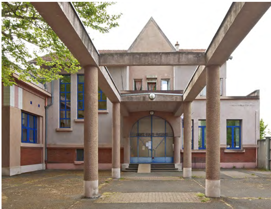
vue de la pergola reliant les écoles primaires et maternelles
