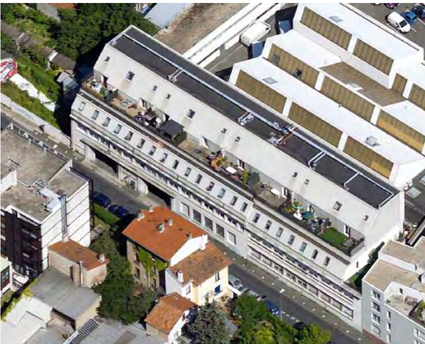
Le site avant et après réhabilitation, vue oblique de 2006.
