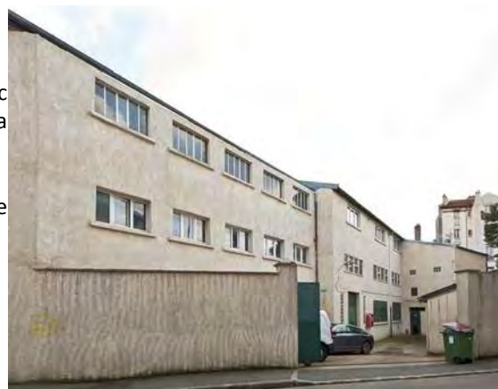
Vue du site depuis la rue Dombasle.
