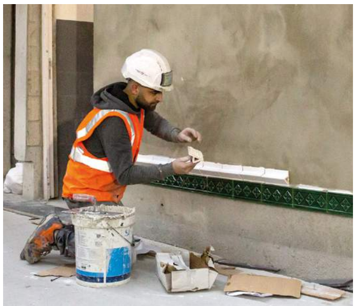
Sur les murs des stations, toute la faïence dite « métro » est posée carreau par carreau, à l'ancienne.
