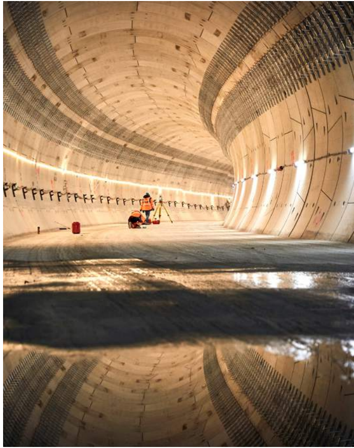
Le tunnelier a dans le même temps creusé et fabriqué le tunnel, à l'aide de pièces de béton préfabriquées.
