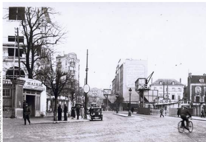
L'entrée de la station de métro Mairie de Montreuil en 1937. À l'arrière-plan, l'hôtel de ville encore en construction.
