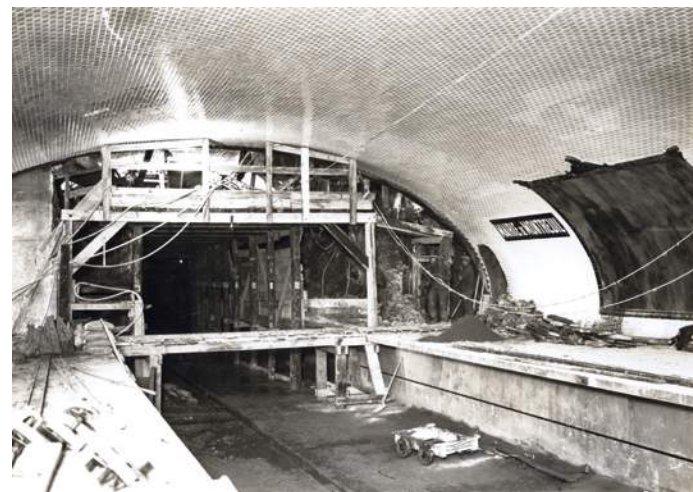
La station Mairie de Montreuil quelques jours avant l'achèvement des travaux et son inauguration.
