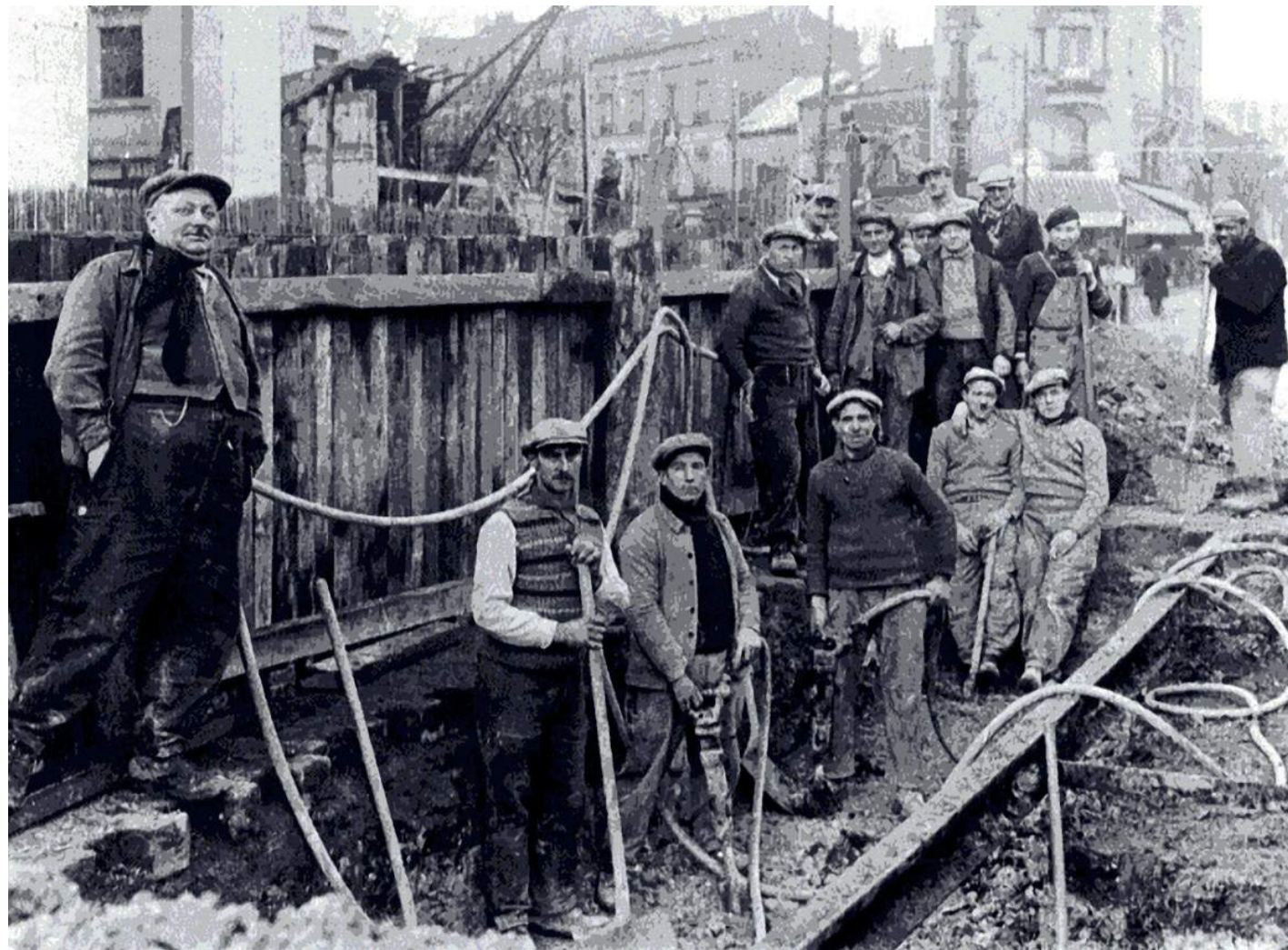
Les ouvriers travaillant sur le chantier du prolongement de la ligne 9.
