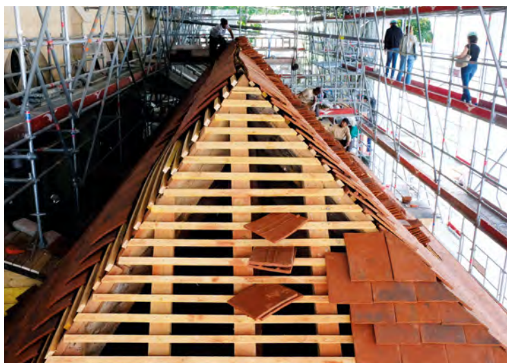
Le toit de la chapelle de la Vierge en cours de réfection.
