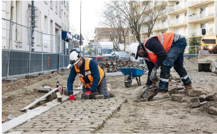
Pose de pavés rue François-Debergue.
