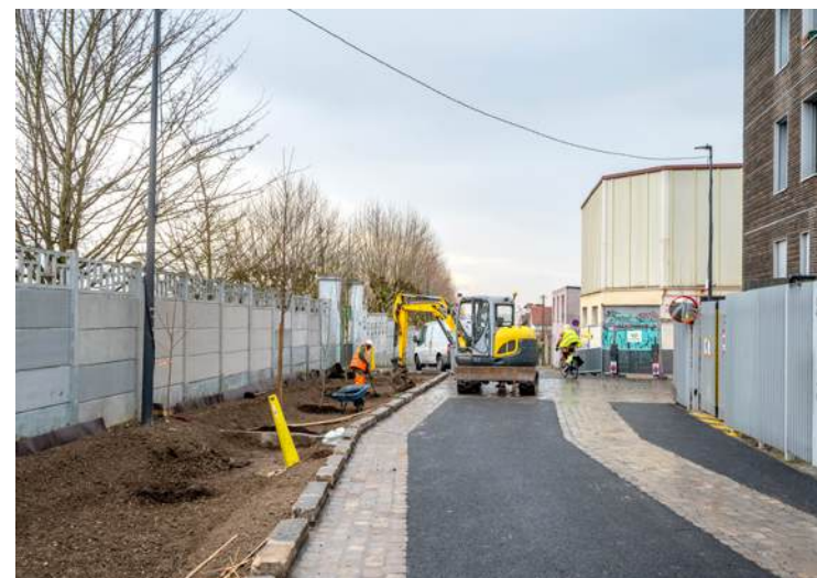
La rue des Soucis refaite à neuf et désormais végétalisée.
